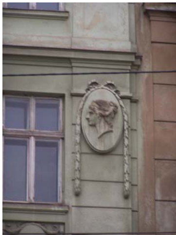
Оздоблення будинку по вул. С.Бандери, 3.
