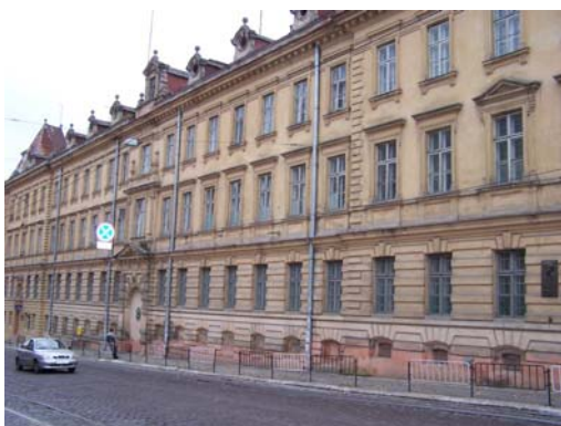
Адмінбудинок будинок по вул. Бандери С., 1.
