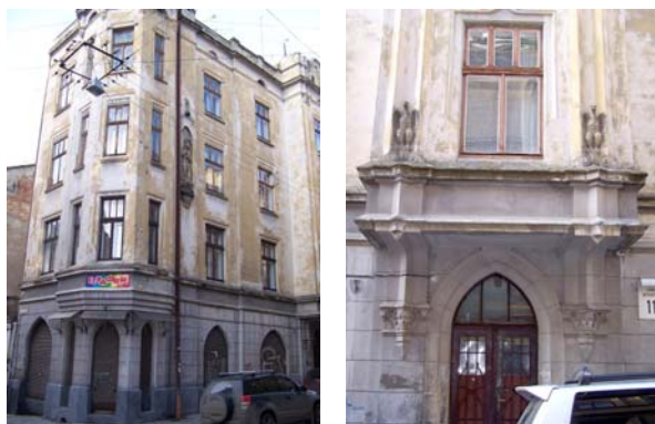
Житловий будинок по вул. Друкарській, 11.
