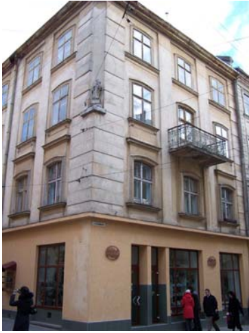
Житловий будинок по вул. Галицька, 13.
