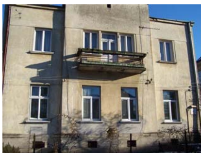
Фасад будинку по вул. Барвінських, 7.
