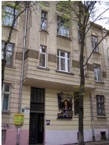
Житловий будинок по вул. Архітекторська, 7
