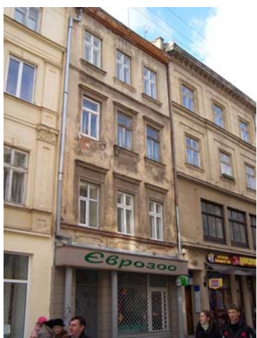
Житловий будинок по вул. Галицька, 12.
