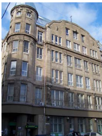
Житловий будинок по вул. Галицька, 21.
