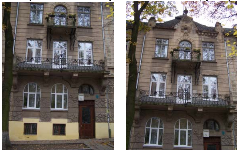
Житловий будинок по вул. Архітекторська, 5.
