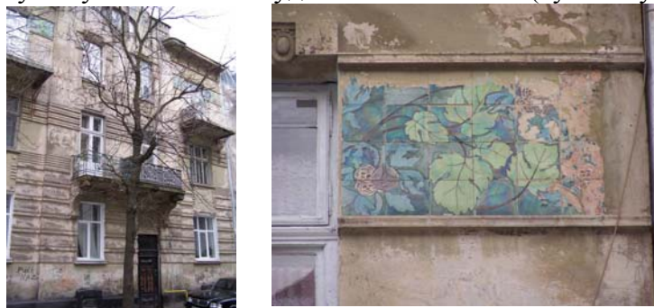
Фасад будинку по вул. Богуна, 5.
