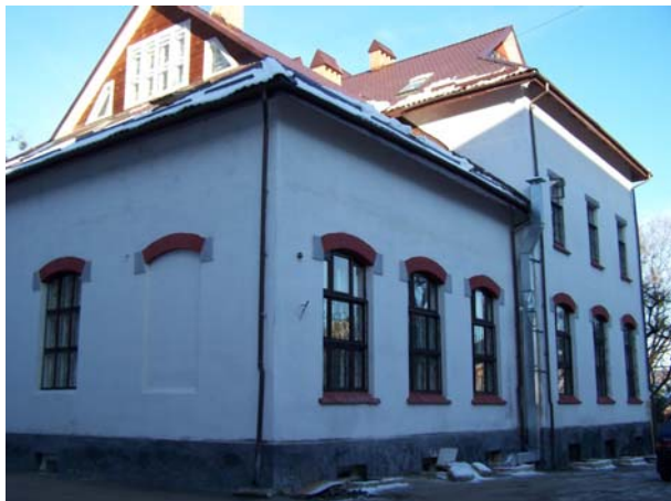
Фасад будинку по вул. О.Басараб, 2.
