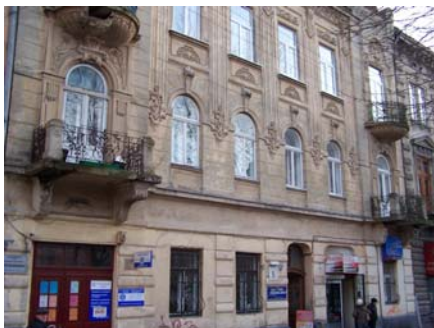
Житловий будинок по вул. Вороного, 5.
