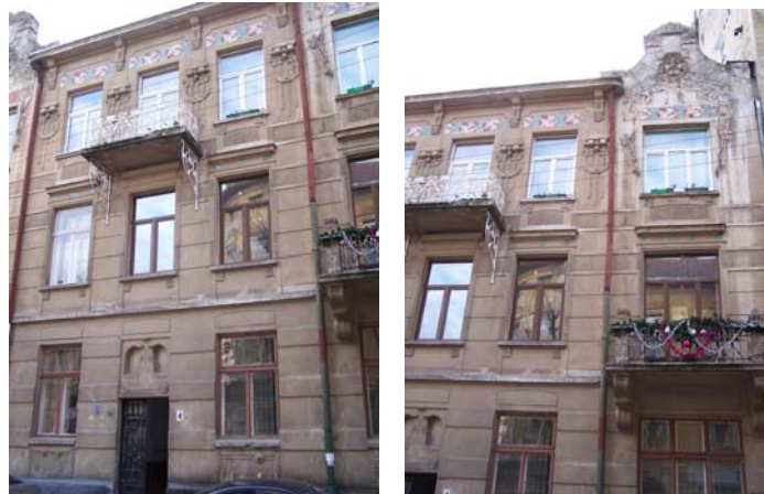
Житловий будинок по вул. Богомольця, 4.
