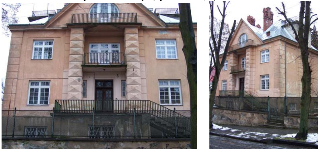
Житловий будинок по вул. Глінки, 3.
