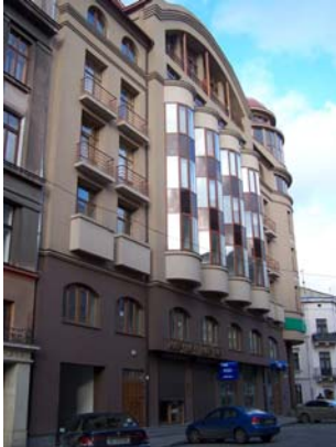
Будинок по вул. Валова, 15.
