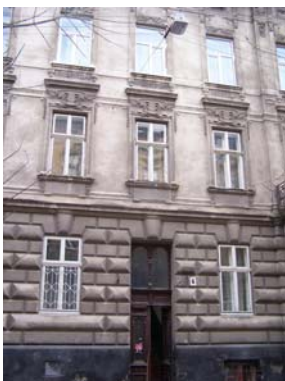
Житловий будинок по вул. Верхратського, 6.
