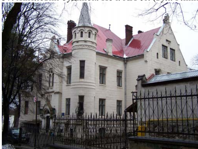
Житловий будинок по вул. Глінки, 1.
