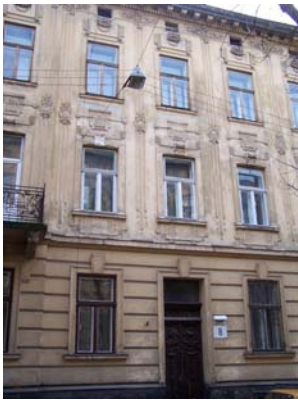
Житловий будинок по вул. Верхратського, 8.
