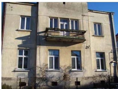
Фасад будинку по вул. Барвінських 7.
