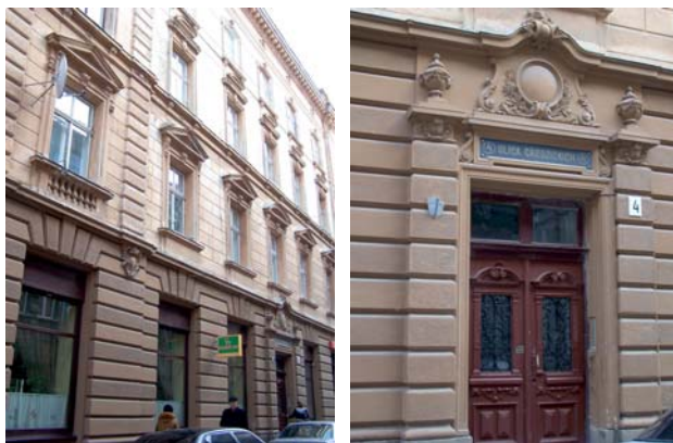
Житловий будинок по вул. Друкарській, 4.
