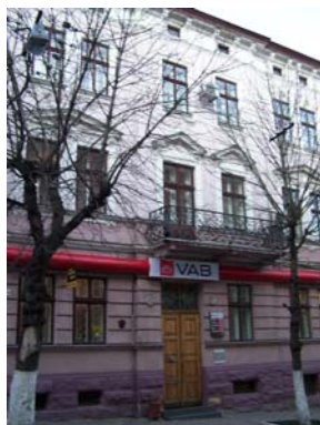
Житловий будинок по вул. Драгоманова, 18.
