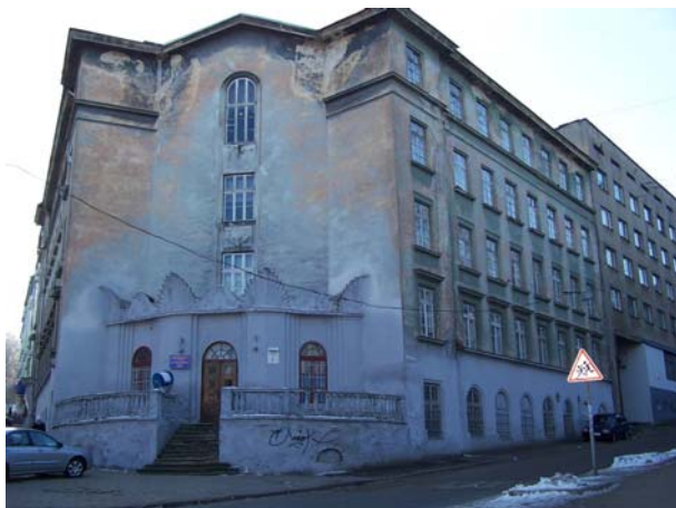
Фасад будинку по вул. О.Басараб, 1.
