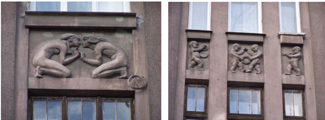
Скульптурні рельєфи над вікнами будинку по вул. Валова, 13.
