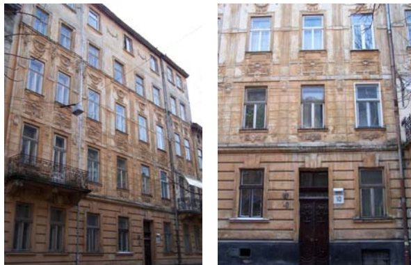
Житловий будинок по вул. Верхратського, 10.
