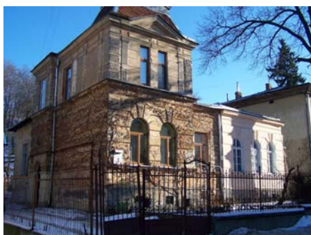
Фасад будинку по вул. Барвінських 9.
