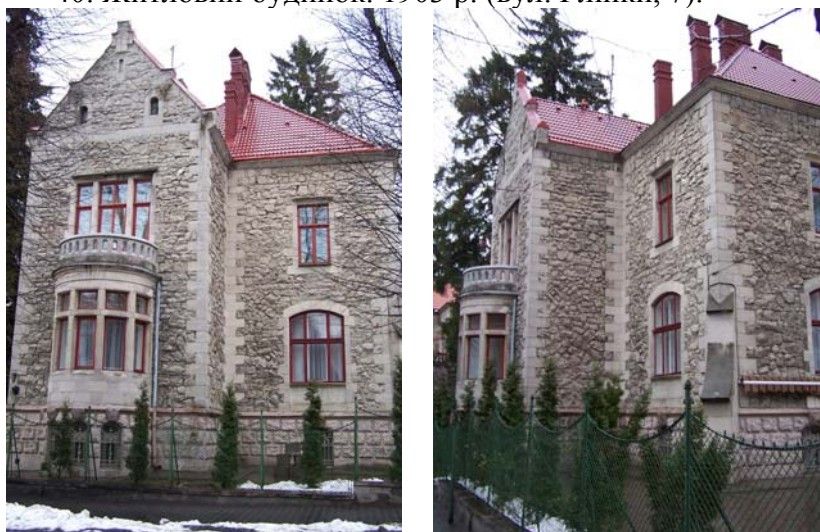
Житловий будинок по вул. Глінки, 7.
