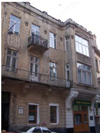
Житловий будинок по вул. Вороного, 9.
