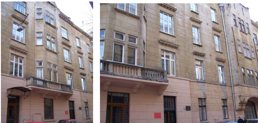
Житловий будинок по вул. Богомольця, 2.
