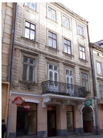
Житловий будинок по вул. Галицька, 15.
