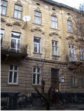
Житловий будинок по вул. Верхратського, 7.
