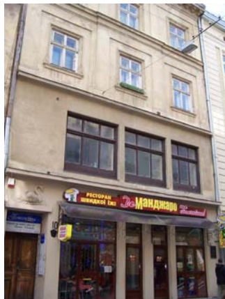
Житловий будинок по вул. Галицька, 10.
