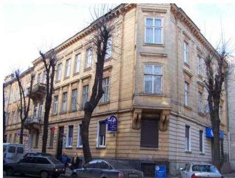
Житловий будинок по вул. Богомольця, 15.
