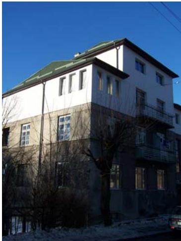
Фасад будинку по вул. Барвінських 16.
