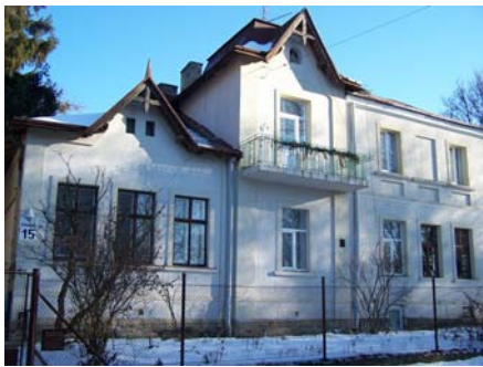
Фасад будинку по вул. Барвінських 15.
