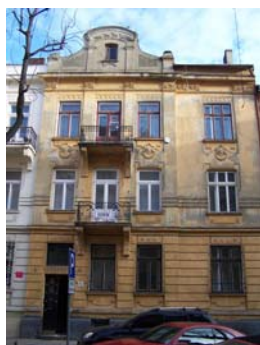
Житловий будинок по вул. Богомольця, 11.
