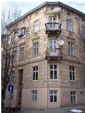
Житловий будинок по вул. Верхратського, 15.
