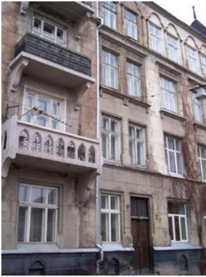
Фасад будинку по вул. Брюлова, 2.
