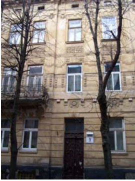
Житловий будинок по вул. Верхратського, 9.
