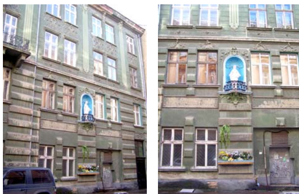
Житловий будинок по вул. Друкарській, 3.
