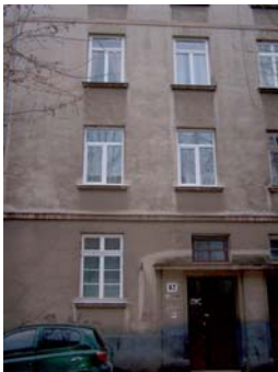
Житловий будинок. (вул. Єфремова, 62).
