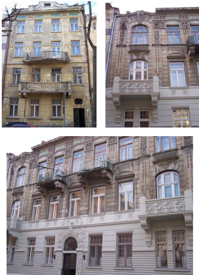
Житловий будинок по вул. Богомольця, 6
