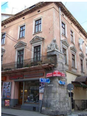
Житловий будинок по вул. Галицька, 11.
