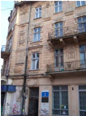
Житловий будинок по вул. Вороного, 3.
