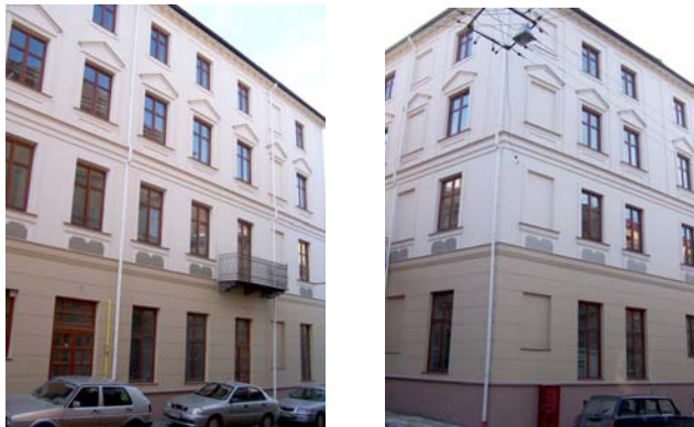
Житловий будинок по вул. Друкарській, 9.
