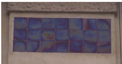
Керамічні вставки на фасаді будинку по вул. Донцова, 8.
