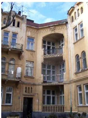
Житловий будинок по вул. Богомольця, 7.
