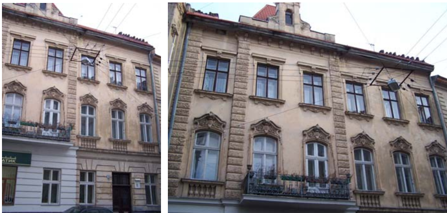
Житловий будинок по вул. Вороного, 11.
