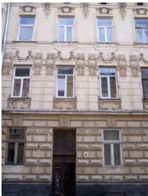
Житловий будинок по вул. Верхратського, 4.
