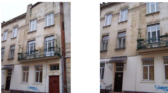
Фасад будинку по вул. Брюлова, 6.
