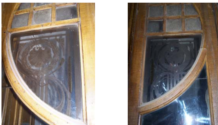
Оздоблення вікон у будинку по вул. С.Бандери, 4
