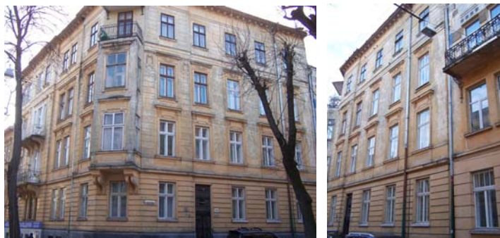
Житловий будинок по вул. Богомольця, 10.
