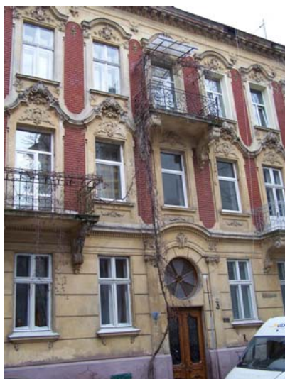
Фасад будинку по вул. Богуна, 3.
