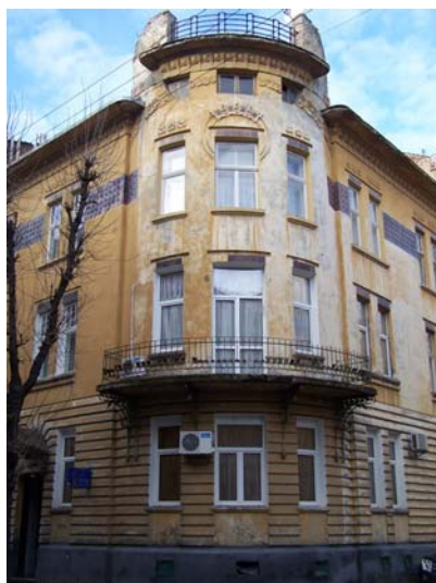
Житловий будинок по вул. Богомольця, 3.
