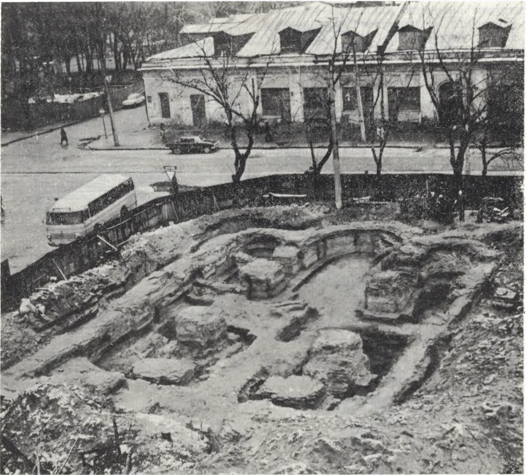
Рис. 33. Залишки фундаментів і стін церкви Пирогощі. Контрактова площа. 1976—1978.
