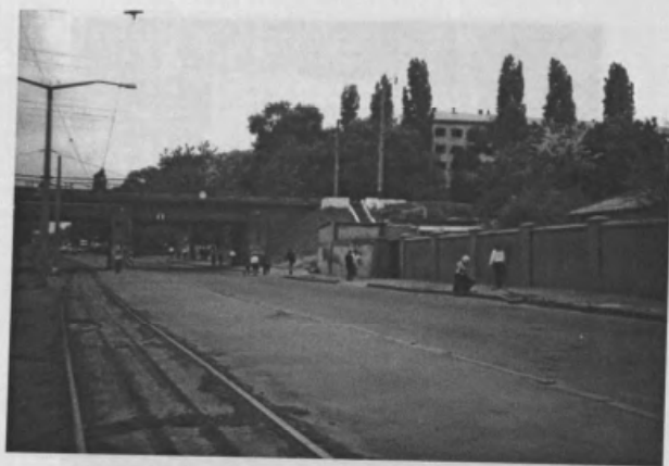
Ул. Маловского (Слободка), по которой в 1941 г. гнали евреев в гетто, и мост, где находился пропускной пункт в гетто. Фото В. Тартаковского. Предоставил Л. Дусман
