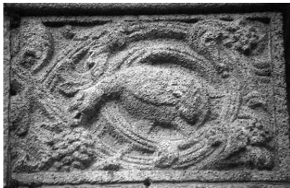
306.3. Деталі оздоблення фасаду.
