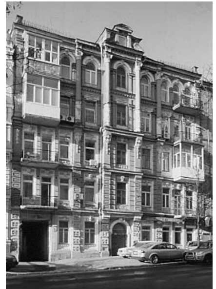
467.10. Вул. Ш. Руставелі, 30.
