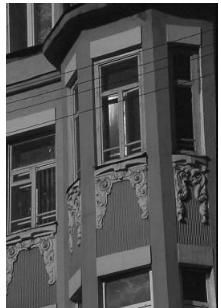
486.52. Фрагмент оздоблення еркера.
