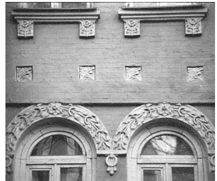
249.5. Фрагменти оздоблення фасаду.
