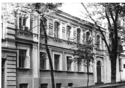
249.12. Вул. Мала Житомирська, 9-б.
