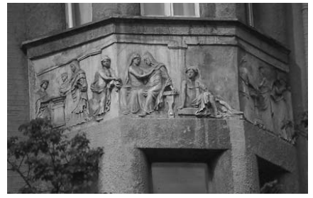
486.3. Фрагмент оздоблення еркера.
