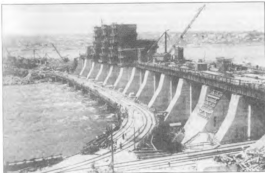
Строительство плотины Днепрогэса им. В. И. Ленина. 1929 г.
