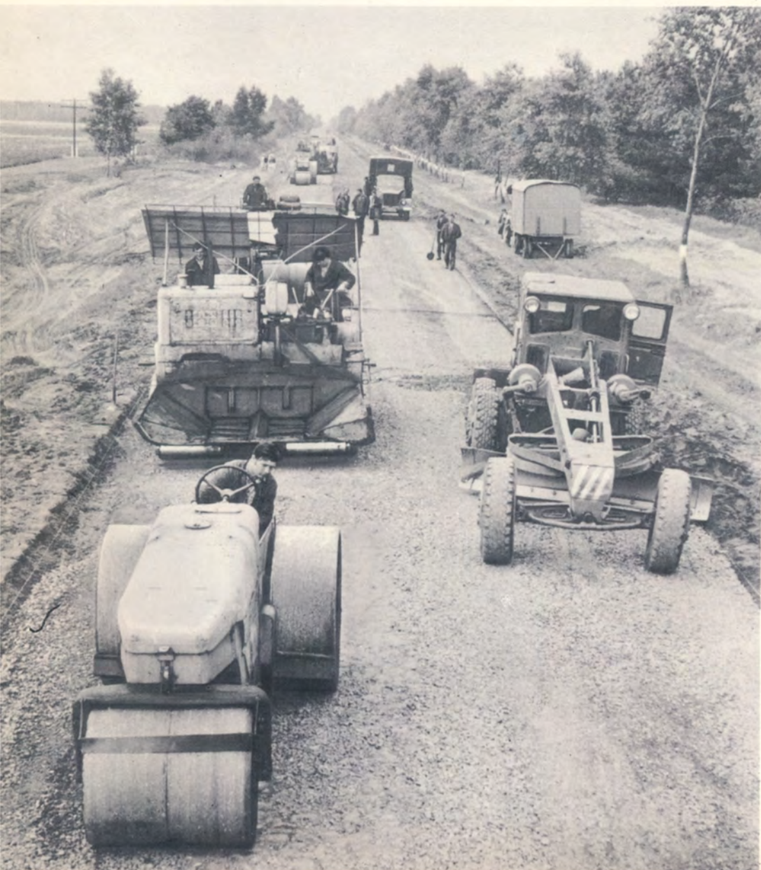
Будівництво дороги в Сарненському районі, 1972 р.
