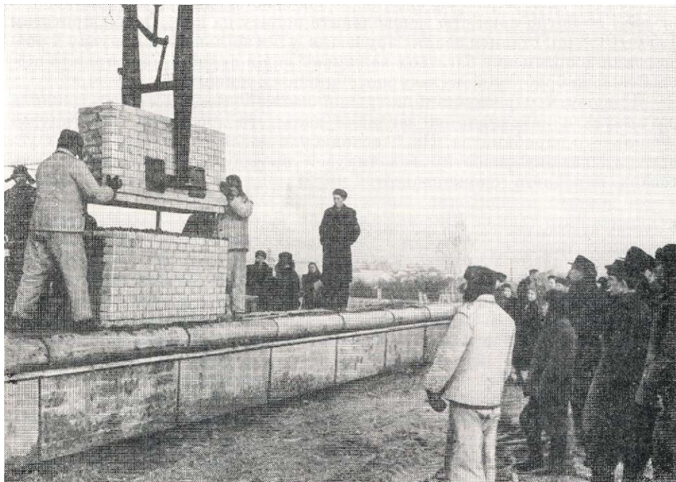
Бригада монтажників (Київська область) демонструє установку цегляних блоків на фундамент будинку (1955 р.).
