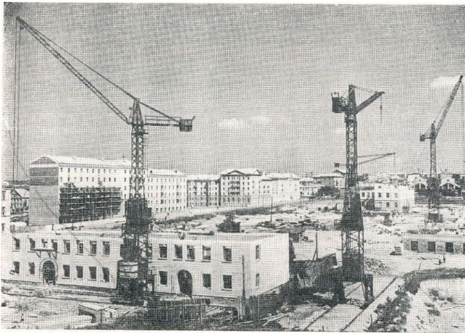
Будівництво нового житлового кварталу в м. Сталіно (1957 р.).
