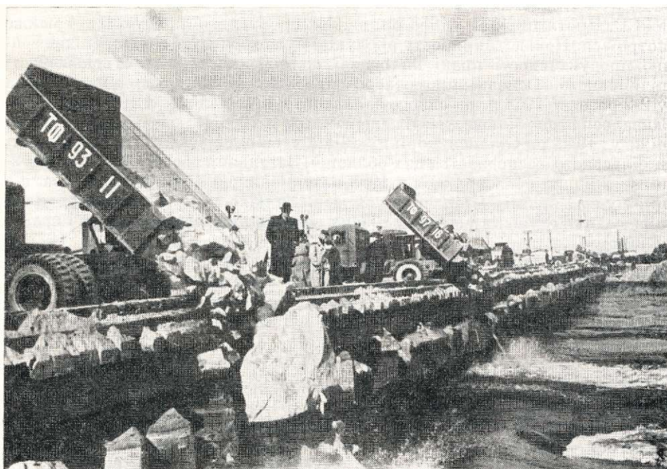
Перекриття Дніпра під час будівництва Кременчуцької ГЕС (1957 р.).
