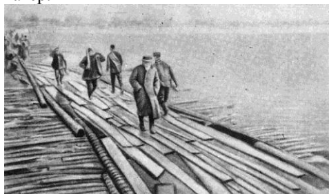
На Припяти. Мост готов
