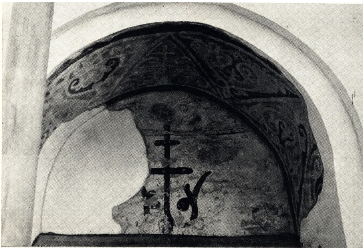
Рис. 1. Роспись в нише на западном фасаде.
