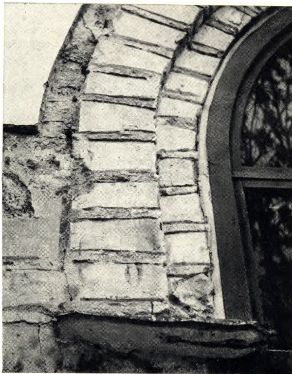
Рис. 2. Дверной проем северной башни.
