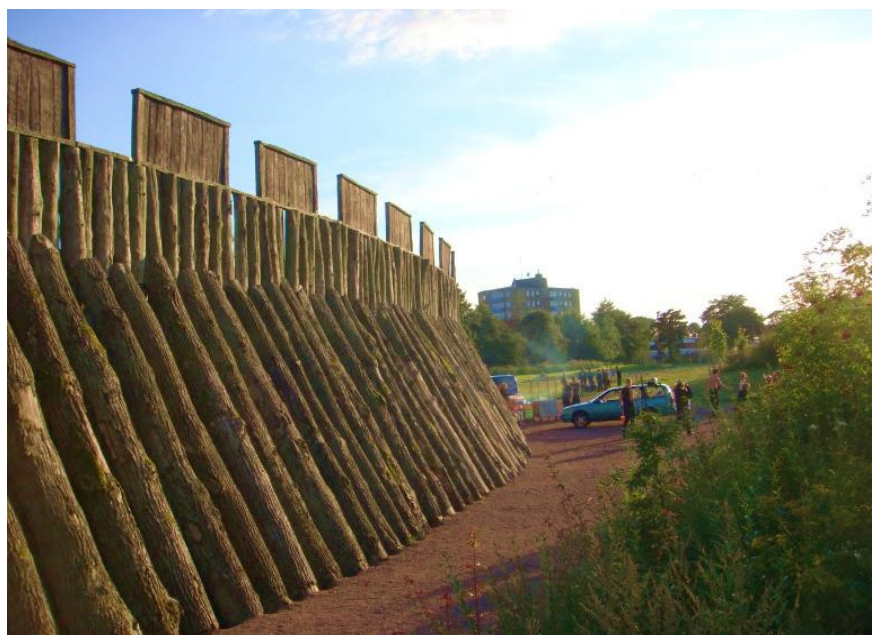
Ил. 14. Реконструкция поселения викингов. Оборонная стена. Вид со стороны поля. Дубовые наклонные бревна, подпирающие вертикальные стойки парапета, выполняют функции контрфорсов, которые гасят давление грунта со стороны городища. Дания, г. Фуркат. Фото В. В. Янченко.
